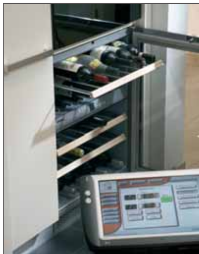
Bild 2. Über eine serielle Schnittstelle sind die Liebherr-Kühlgeräte in das System eingebunden und Störungsmeldungen werden auf den Touchpanels und im Notfall auch akustisch angezeigt.
