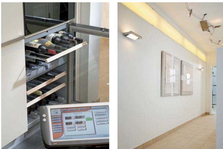
Links: Über ein serielle Schnittstelle verfügen Kühl- und Weinklimaschrank über eine Anbindung an die Steuerungstechnik. Rechts: Damit das Haus auch bei Abwesenheit nicht auffällt, ist mit einer Anwesenheitssimulation ausgestattet.
