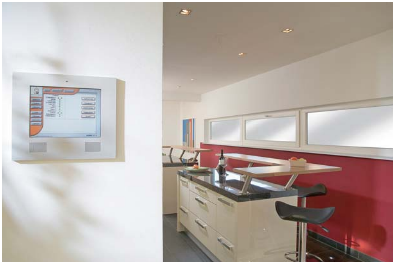
Guckloch: Dank einer automatischen Bildeinspielung bei der Haustür sieht man auf allen Touchpanels, wer geklingelt hat.
